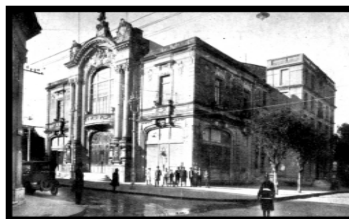
Otra foto de la misma época muestra arbolitos en la vereda. Se mantienen en ambas los destacados faroles de pie, de gran altura. La fachada registra también en las dos, un detalle hoy faltante: los importantes cálices que rematan las barandas de todos los balcones. (Archivo del Museo de la Ciudad.)
