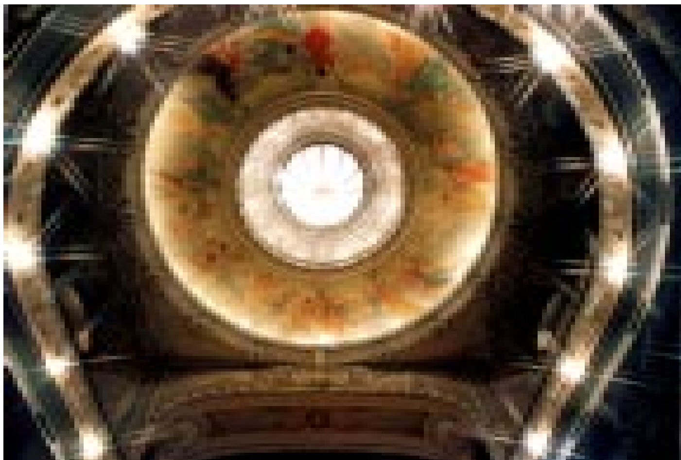
Detalle de la cúpula, con los tres anillos: araña circular y pintura mural.
